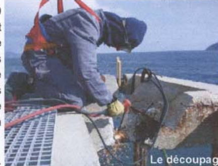
Le découpage à la lance thermique HP
