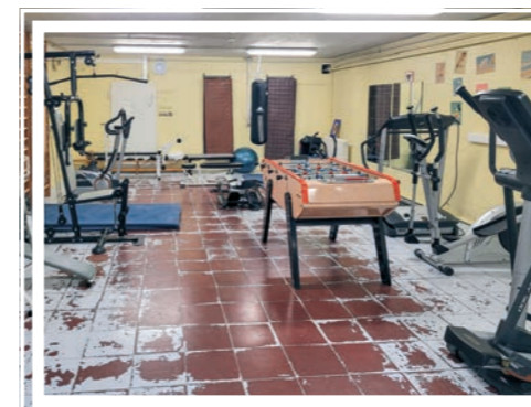
La salle de sport avant les travaux
