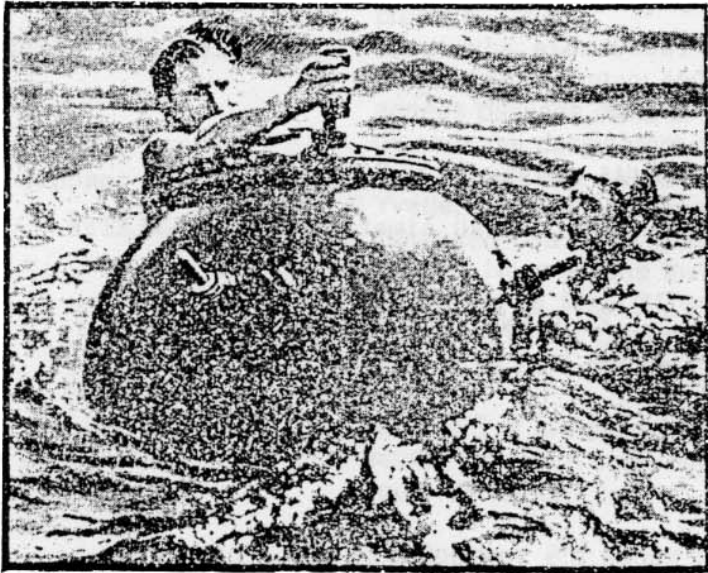
L'un d'eux réussit à fixer un manchon de sécurité sur l'une des cornes en métal tendre qui sont les détonateurs de la mine. Ainsi protégée la corne ne risque plus de provoquer l'explosion. Mais une maladresse aurait pu provoquer l'explosion.
