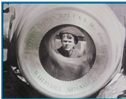
L'introduction du chargement par la culasse et le rayage des canons change complètement leurs performances. Le canon Rodman de 10" (28 cm) tirait un boulet de 60 kg à 3 600 m, le même, une fois rayé, tire un obus cylindro-ogival de 300 kg à 11 200 m.
