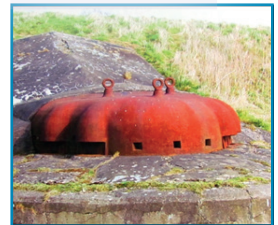
Casemate cuirassée du Fort Hoofddorp (Amsterdam)
