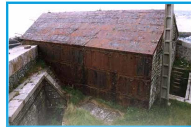
Le poste extérieur "E" est implanté dans l'angle Est de l'ouvrage 2 de Querqueville. Sa disposition surprend car il est directement incorporé dans le rempart. Il est recouvert de plaques de blindage de 11 cm d'épaisseur provenant du démantèlement du cuirassé Océan à Toulon en 1895. Chose surprenante, le blindage est côté terre, peut-être parce que le poste est sous le feu des 4 canons de 27 c de l'ouvrage 2.
